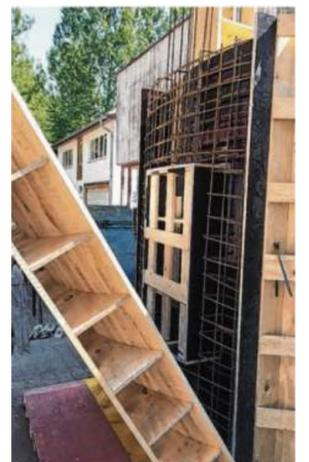
Die Bewehrung im Inneren wurde aus Betonstahl gefertigt.
